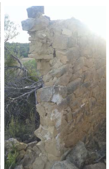
Restos de una de las paredes del mas, sin piedras angulares.
